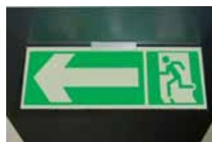
Panneau ÉVACUATION (L. 300 x H. 100 mm) fixé au plafond à l'aide d'un grippeur de 150 mm
